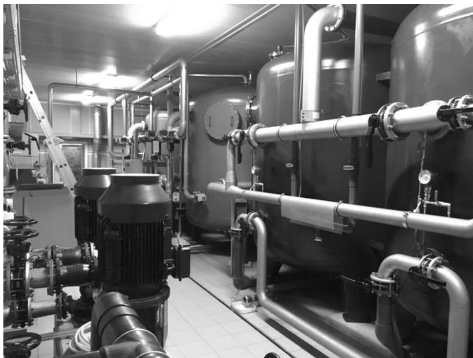
Vue de la station de pompage de la Maison Jaune
