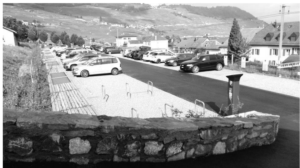
Bâtiment les Fortunades, parking sur le toit
