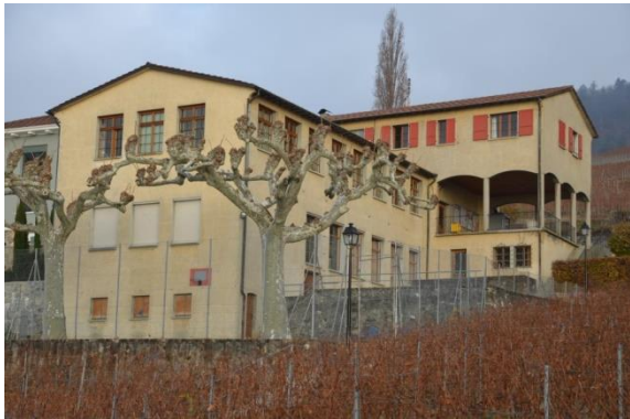
16 - Corniche 24, Eppesses, Maison de commune
