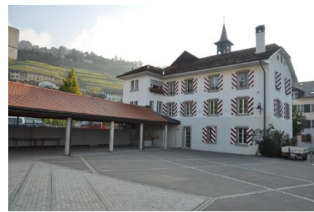
29 - Rue du Village 2, Aran, anc. collège
