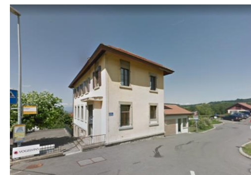
23 - Rte du Signal 81, Grandvaux, anc. collège des Monts
