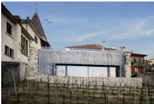
21 - Ch. du Four, Grandvaux, Caveau Corto
