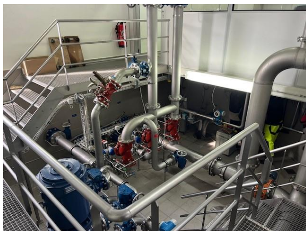
13.11.2025, intérieur du réservoir du Genevrey
