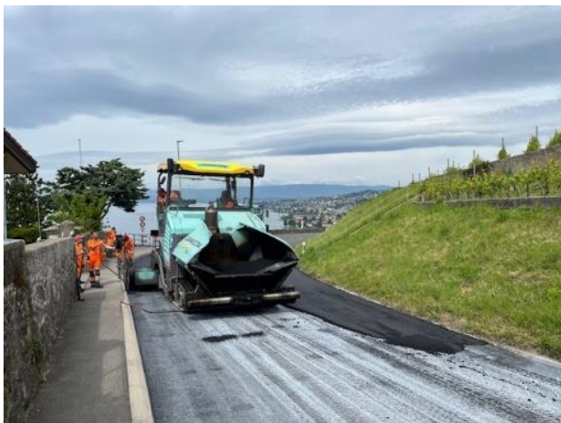
28.05.25 pose de la couche de roulement Petite Corniche
