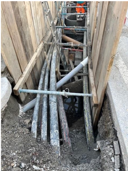
02.12.25, déplacement des conduites électriques du gaz
