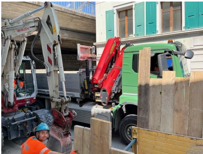
30.04.25, rue de la Gare transit
