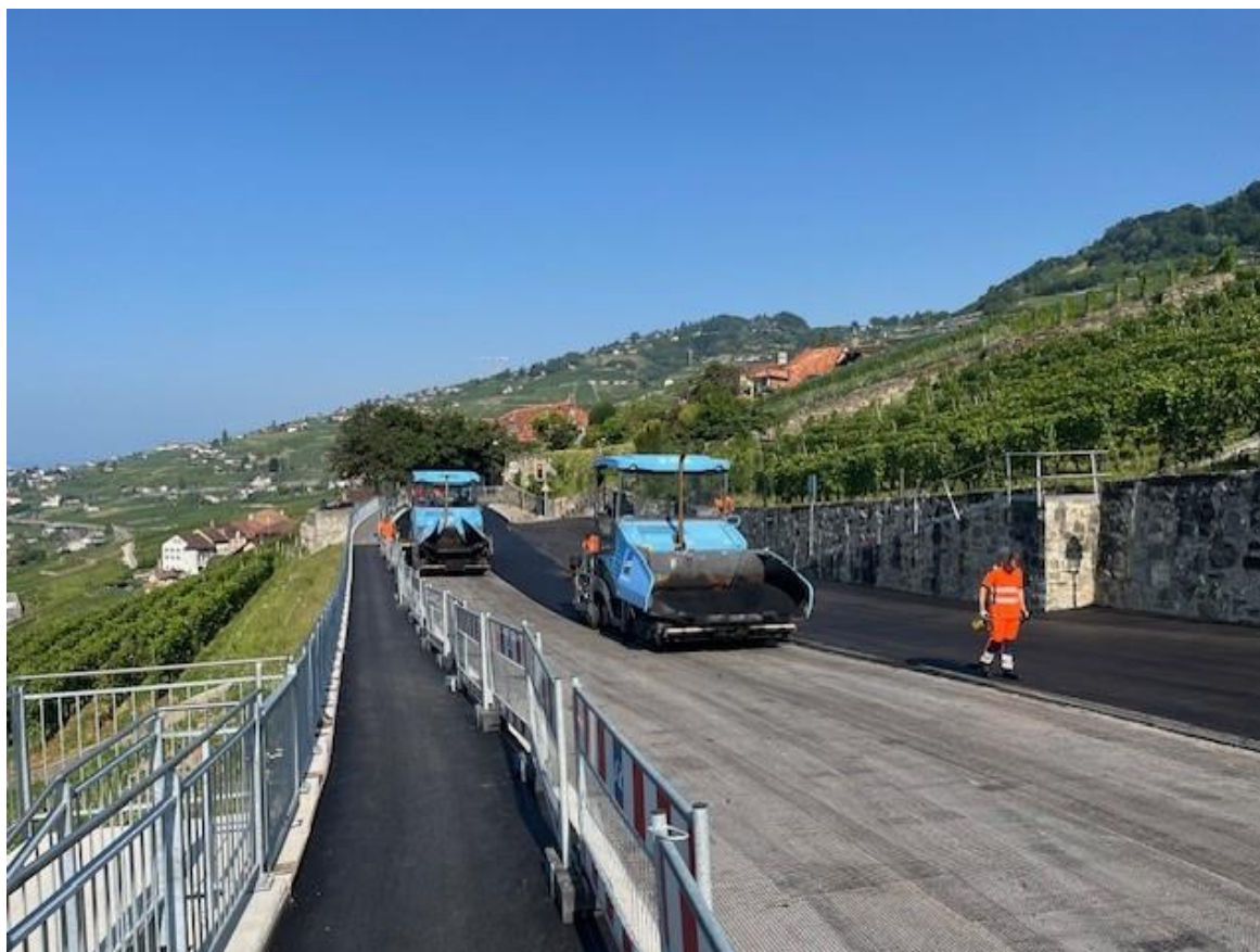
11.08.25 RC 763 Pont des Luges Epesses
