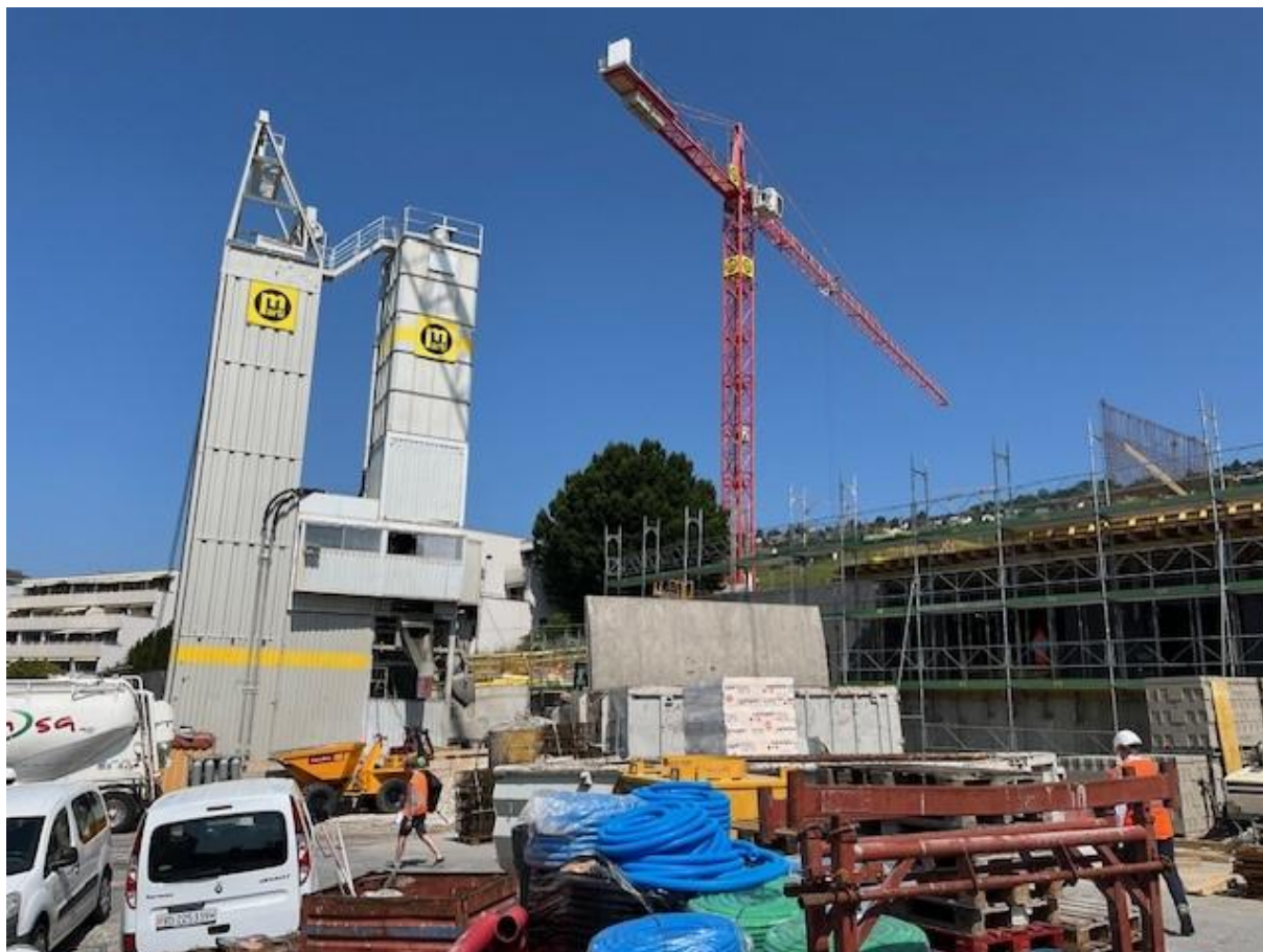
17.06.25 gros œuvre hôpital de Lavaux
