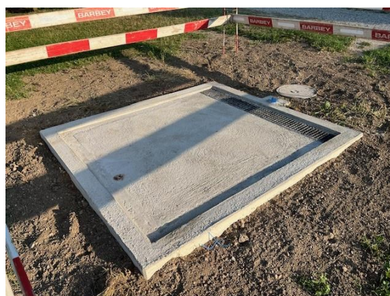
18.06.25 socle en béton
