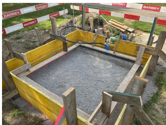
12.06.25 coffrage douche de Moratel
