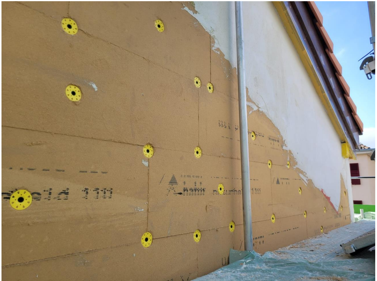
Isolation périphérique d'une villa à Cully
