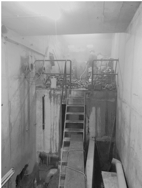
Travaux de démolition de l'appareillage du réservoir et des anciens bassins de réception des sources des Dares et de la Cornallaz.
