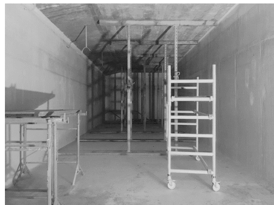
Vue intérieure d'une des cuves du réservoir.
