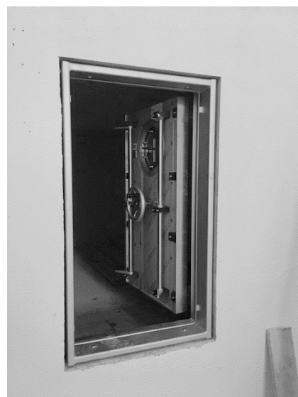
Nouvelle porte étanche des cuves.
