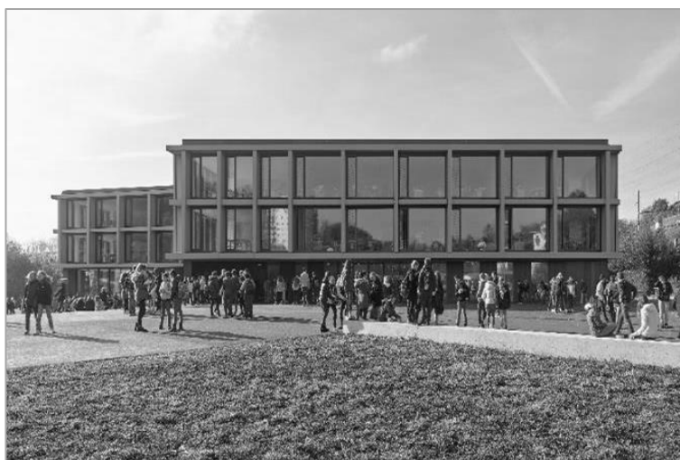
Collège du Verney à Puidoux
