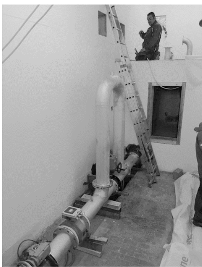
Pose du nouvel appareillage, vue du col de cygne.
