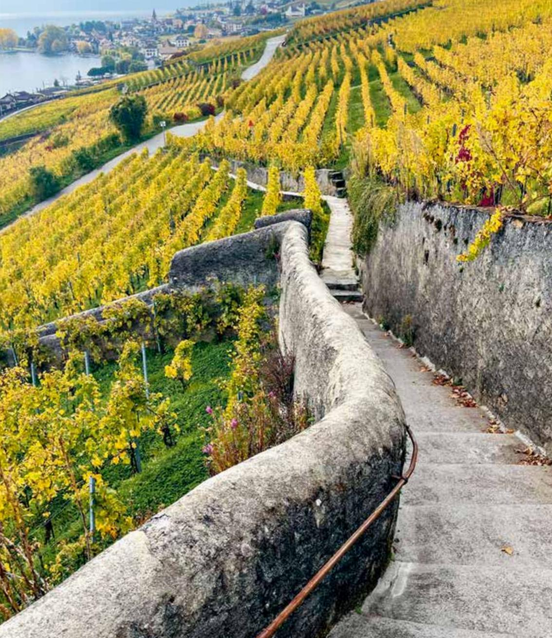
**En l'absence de pierres de couverture, la partie supérieur des murs est façonnée en arrondi pour éviter que l'eau ne stagne et s'infiltra dans la maçonnerie. Le mur est ainsi protégé du gel par un système simple et économique.**
