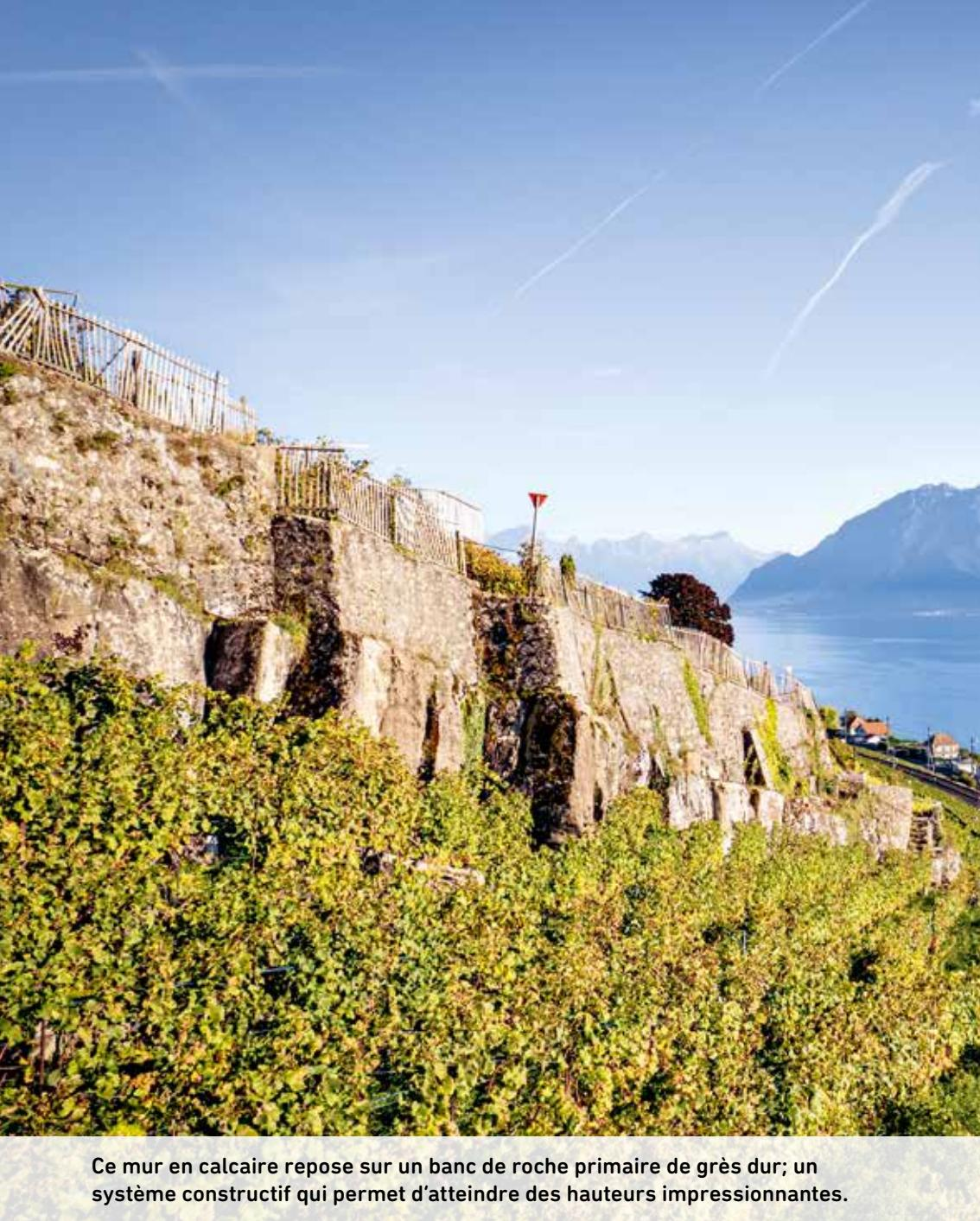
Ce mur en calcaire repose sur un banc de roche primaire de grès dur; un système constructif qui permet d'atteindre des hauteurs impressionnantes.
