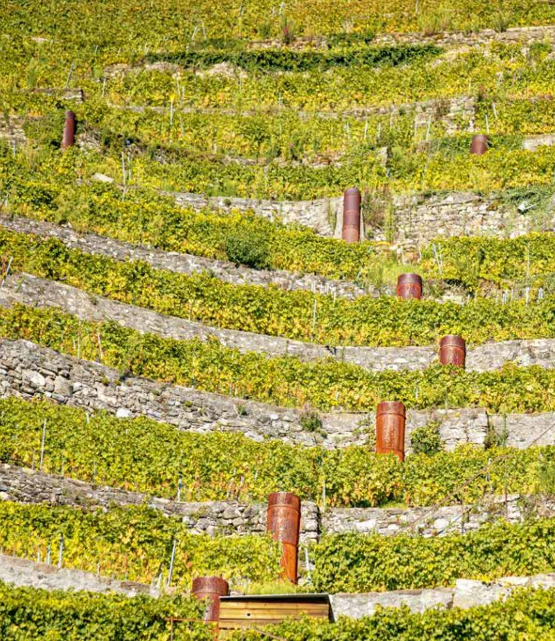
Les tôles de protection qui canalisent la descente d'eau de coulisse en coulisse sont appelés brise-jet. Elles révèlent dans le paysage le système d'évacuation des eaux de surface.
