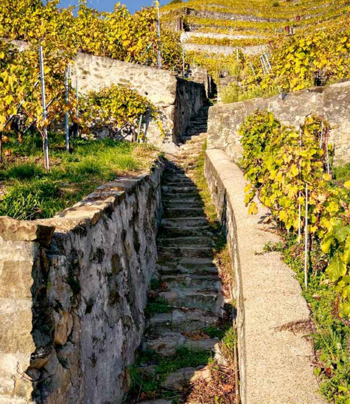
**La double-fonction de cet escalier-coulisse permet l'accès au charmé tout en assurant l'écoulement des eaux de surface.**
